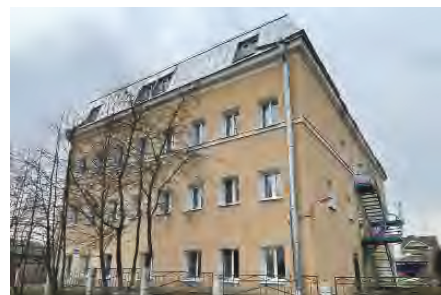
Здание специнтерната в п. Усть-Ижора
